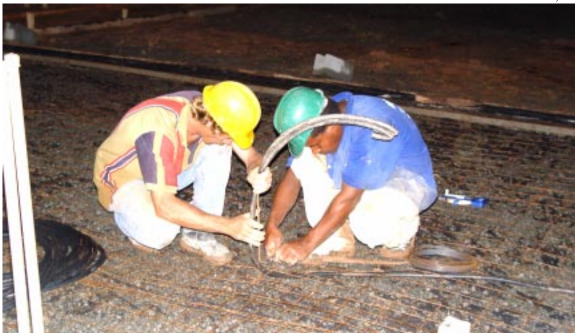
Funcionários da Aprojat já trabalham na área; previsão é de que as novas casas sejam entregues em 8 meses
