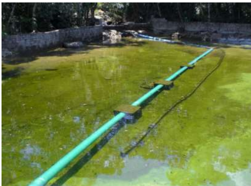
Figura 26 - Tanque de acumulação e vertedouro ao fundo
