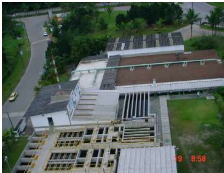
Figura 13 – Estação de Tratamento de Água da Riviera de São Lourenço
