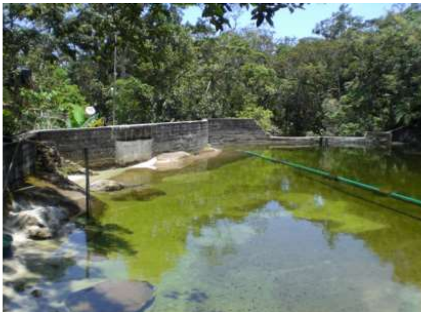
Figura 25 – Vista da Captação Loteamento Morada da Praia
