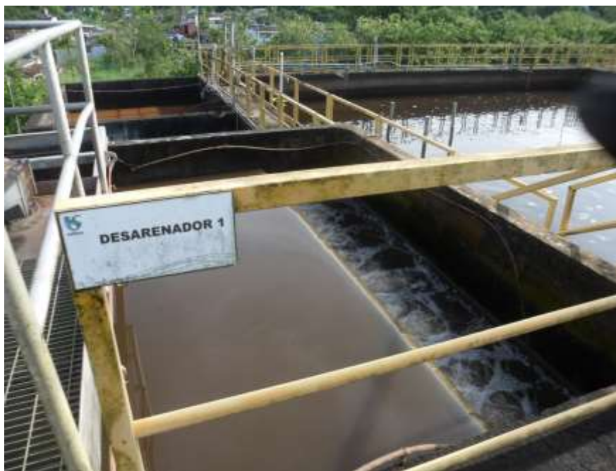
Figura 36 – Processo de desarenação
