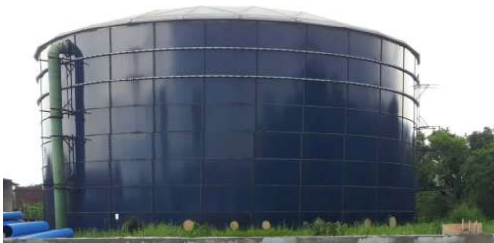
Figura 8 – Foto Reservatório Furnas/Pelaes
