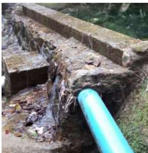
Figura 22 – Detalhe da tubulação da captação
