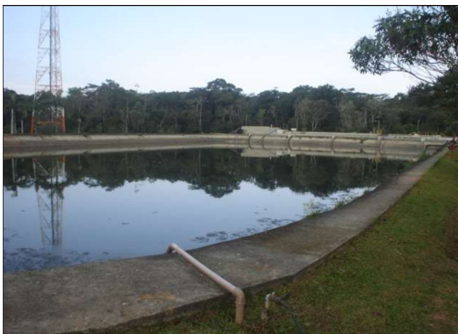
Figura 40 – Lagoa Anaeróbia
