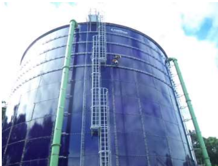
Figura 14 – Tanque reservação Riviera de São Lourenço
