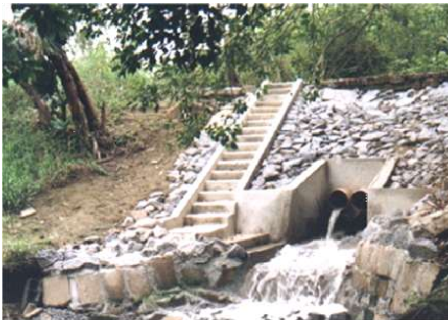
Figura 43 - Lançamento do efluente
