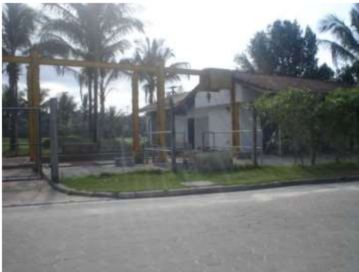
Figura 39 – Estação elevatória de Esgoto
