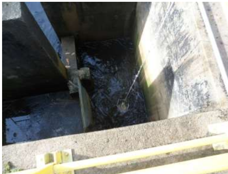
Figura 31 – Chegada do esgoto bruto na ETE Bertioga I
