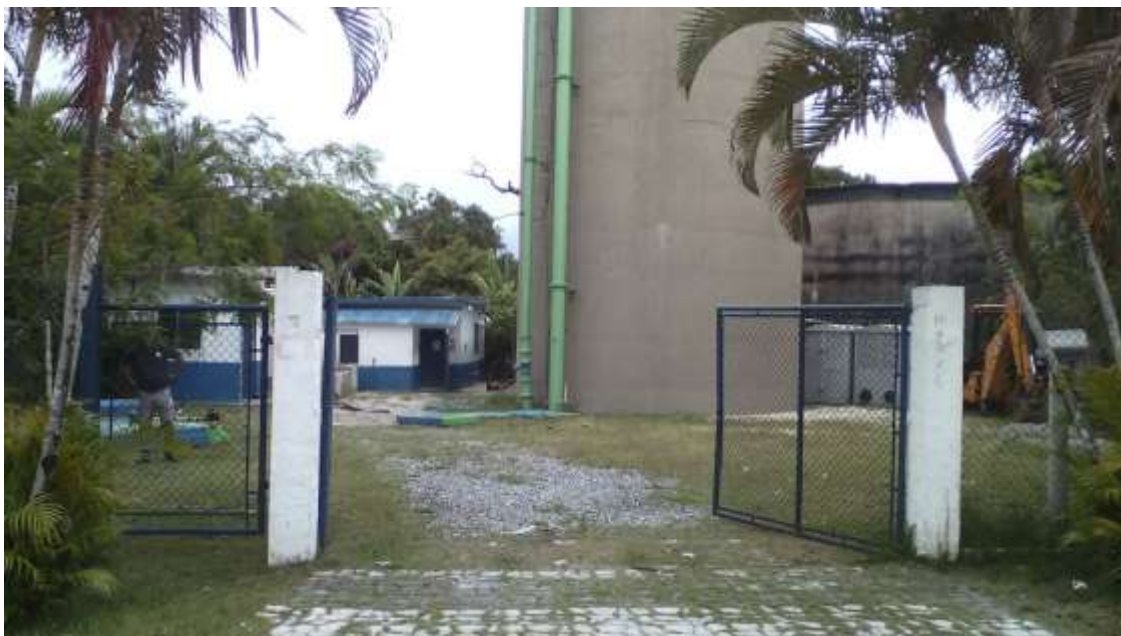
Figura 20 – Vista da ETA Costa do Sol
