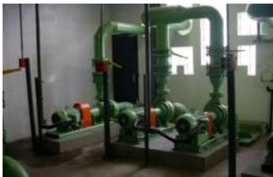
Figura 15 – casa de bomba para distribuição de água
