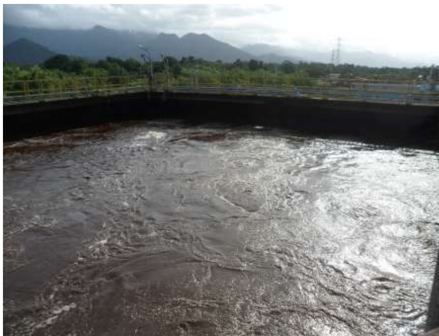
Figura 37 – Tanque de aeração
