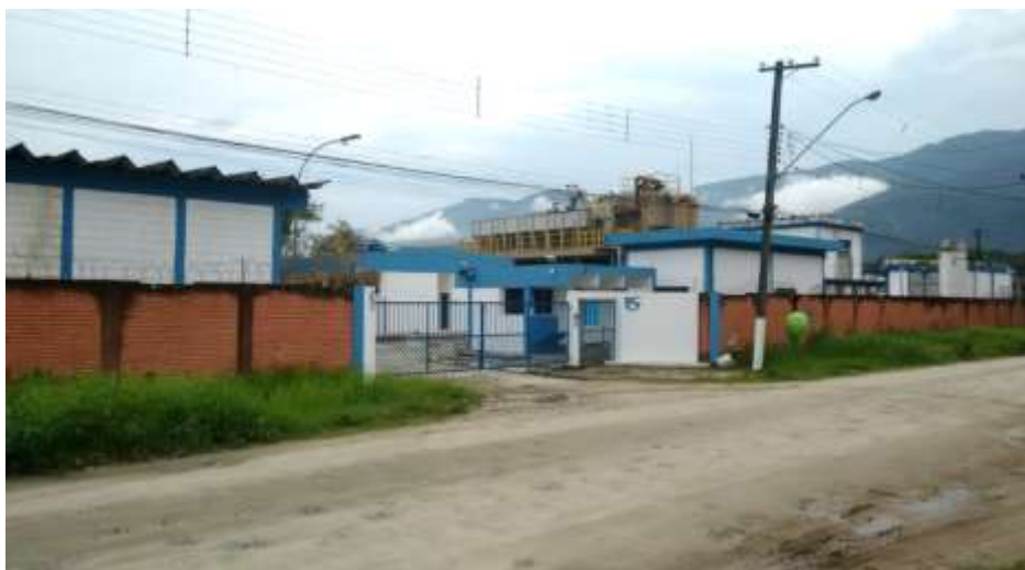
Figura 30 – Vista da ETE Bertioga I
