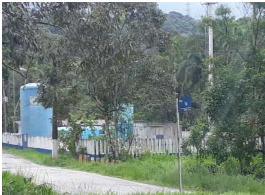
Figura 17 – Vista da ETA Caruara
