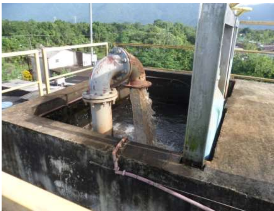
Figura 35 – Chegada do esgoto bruto
