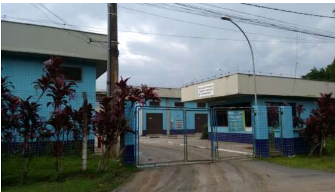
Figura 34 – Vista da ETE Vista Linda
