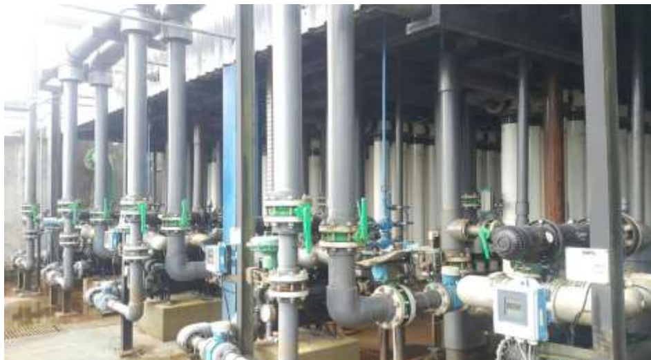
Figura 10 – Sistema Ultra Filtração ETA Itapanhaú
