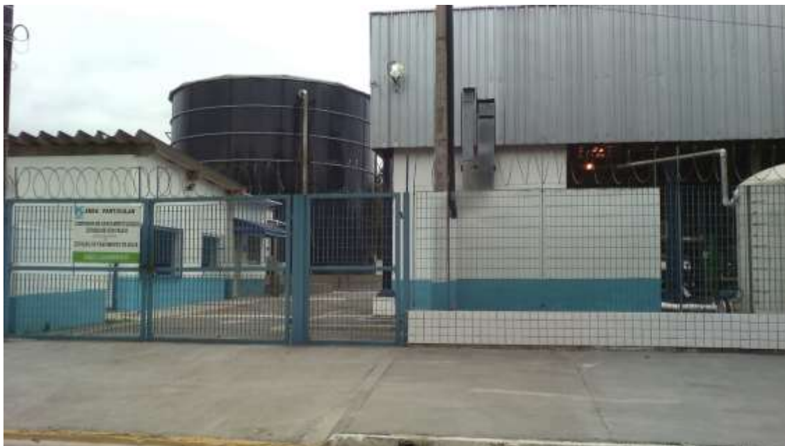
Figura 16 – ETA São Lourenço
