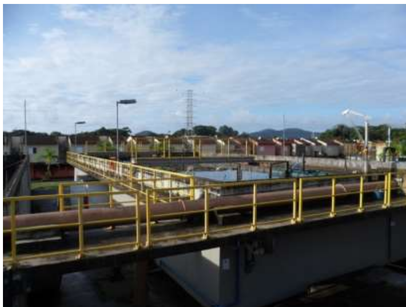
Figura 32 – Módulos de tratamento da ETE Bertioga
