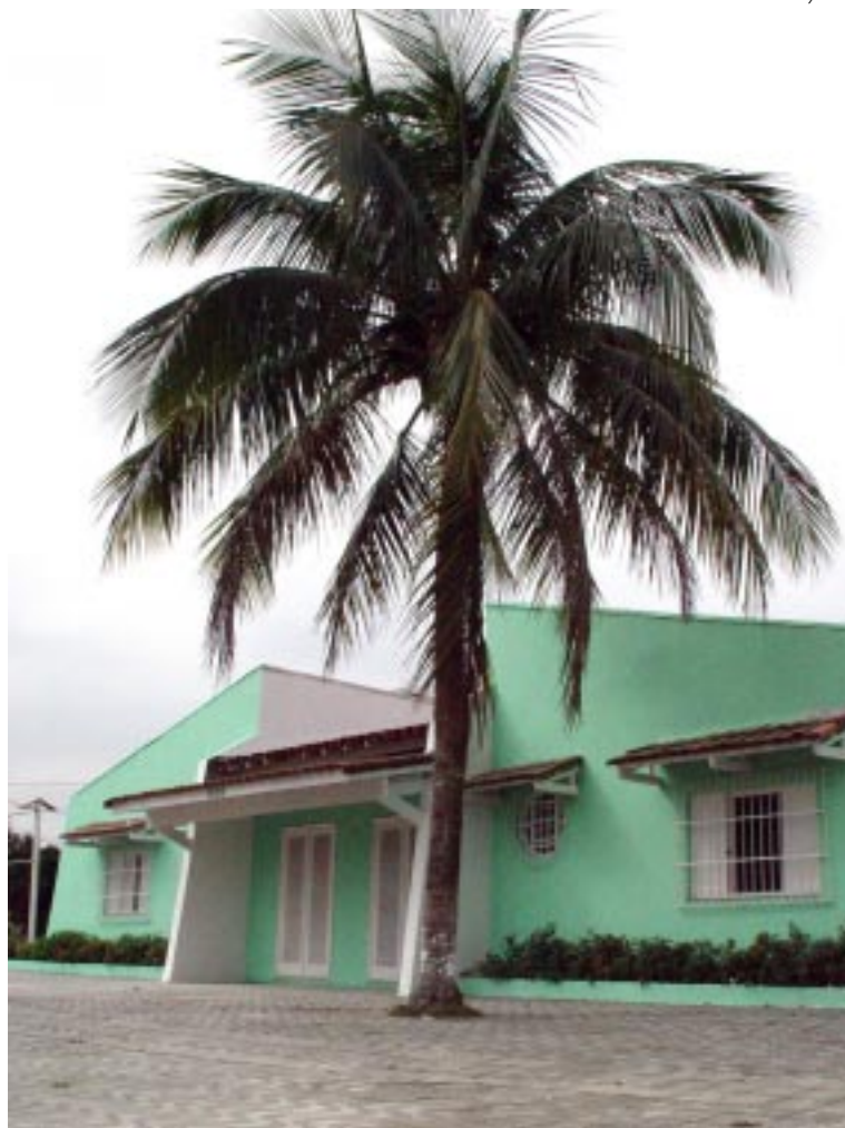
Posto do Procon vai funcionar na Avenida Anchieta, altura dos nºs 1500
