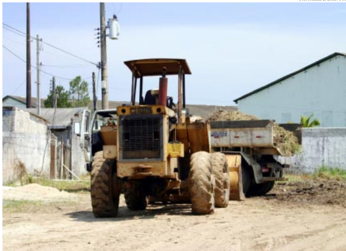
Máquinas da Prefeitura estiveram no bairro durante a semana realizando serviços de limpeza, roçada e nivelamento de ruas
