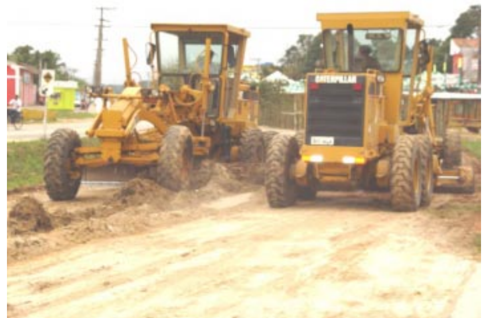
Mutirão de obras da Secretaria de Serviços Urbanos tem percorrido todos os bairros
