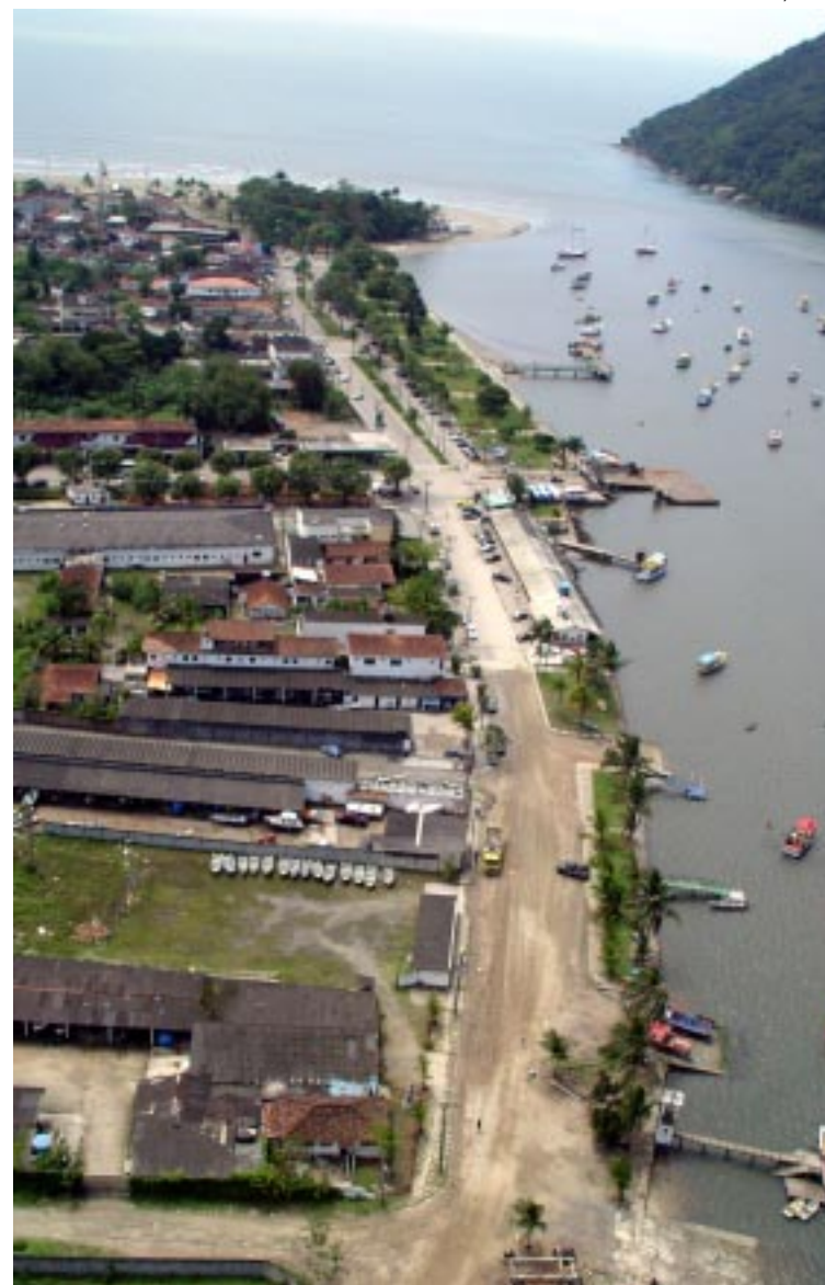
No Jardim Veleiros as obras atingirão os 580 metros compreendidos entre o Mercado de Peixe e a Avenida dos Coqueiros e são estimadas em R$ 1 milhão e 700 mil
