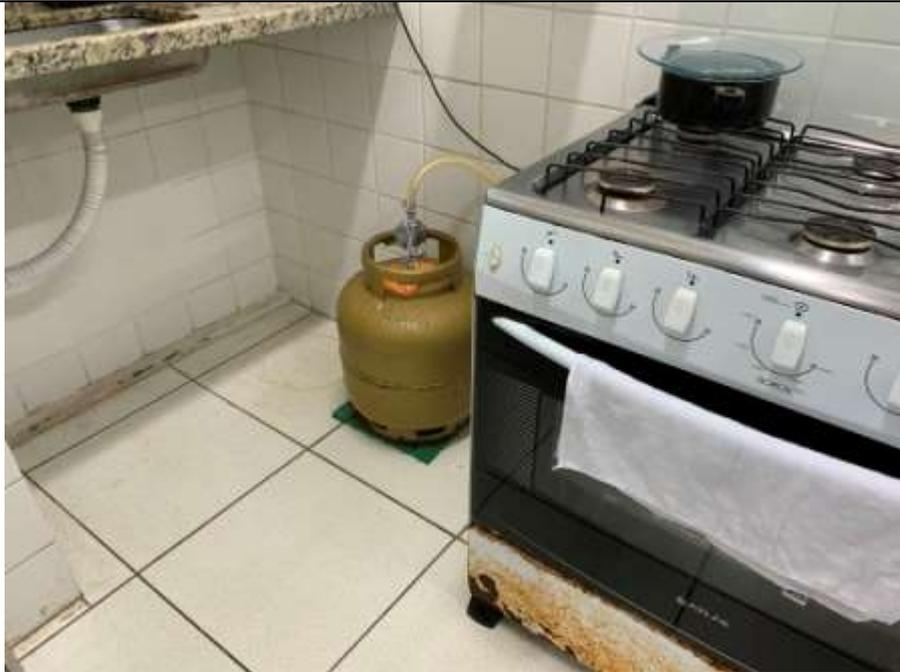
Foto 12 - Botijão de gás instalado em área fechada dentro da cozinha.
