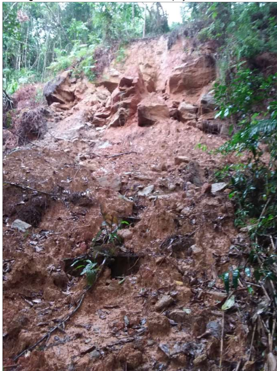
Figura 52 – Deslizamento de terra – ocupação Carvalho Pinto II.
