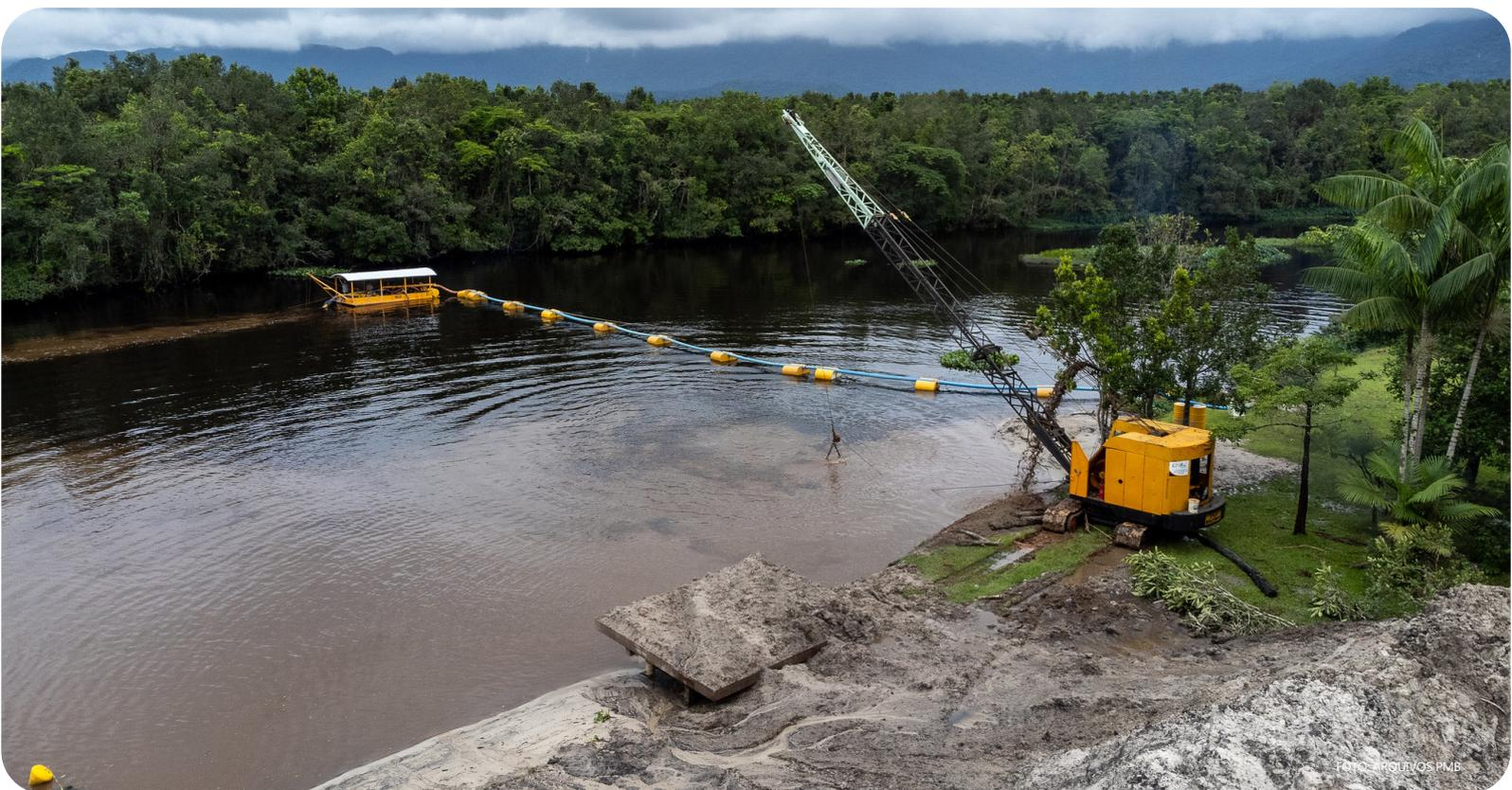
O trabalho inclui limpeza, desassoreamento, alargamento e desobstrução do rio, com a remoção de 26.968 m<sup>3</sup> de sedimentos. As intervenções são destinadas à prevenção de enchentes.
